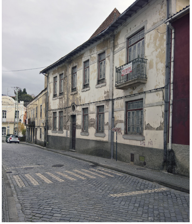
Edifícios a reabilitar na rua da República, Gouveia, 2017.
